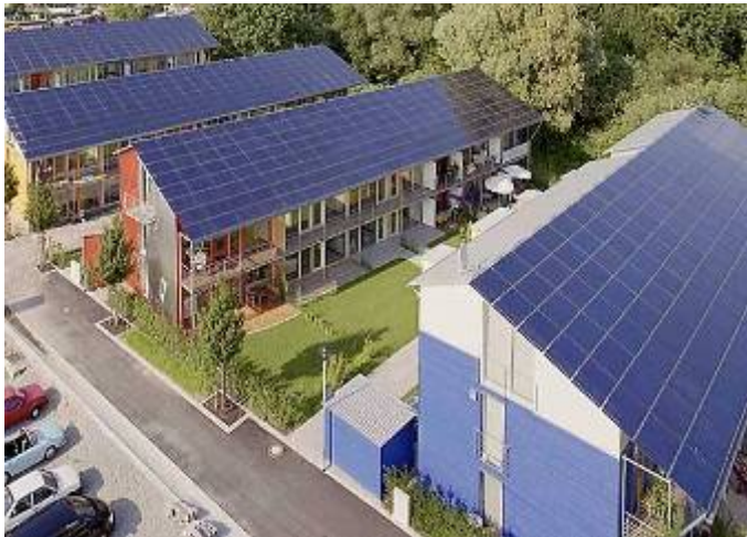
Source : Rolf Disch PlusEnergieHaus
